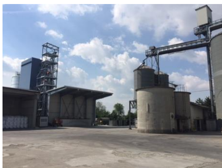
Figura3. Nuovo essiccatoio, trasporti e tettoia
